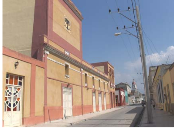
Fig. 34. Vista lateral, calle Maceo.
